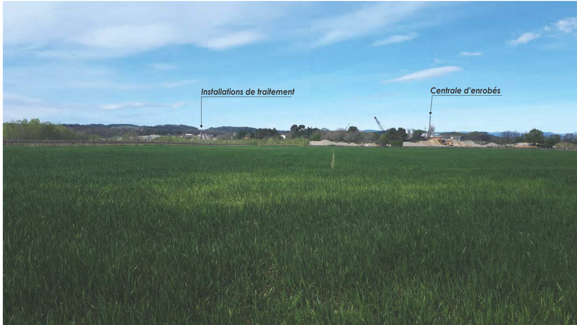
Vue B - Vue vers l'Ouest en direction des installations de traitement et de la centrale d'enrobage à chaud
