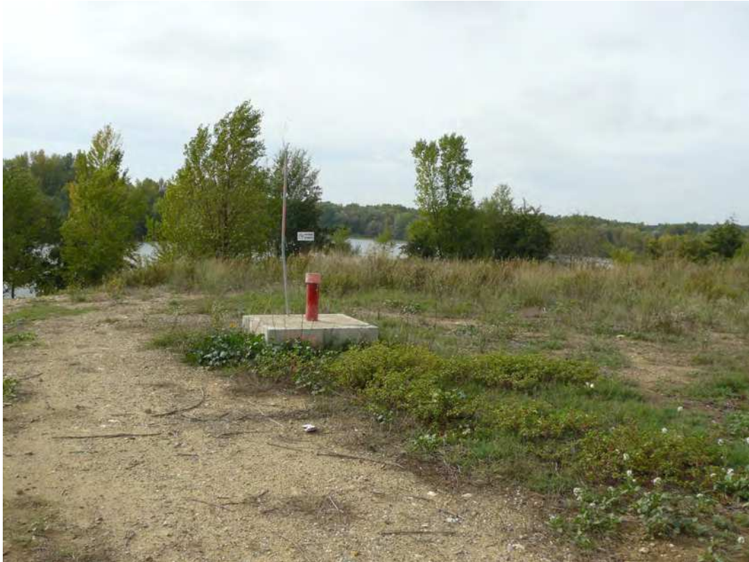
Les abords : des piézomètres pour suivre l'évolution du niveau de la nappe sous-jacente, dont un près du lac, accessible via un chemin périphérique.
