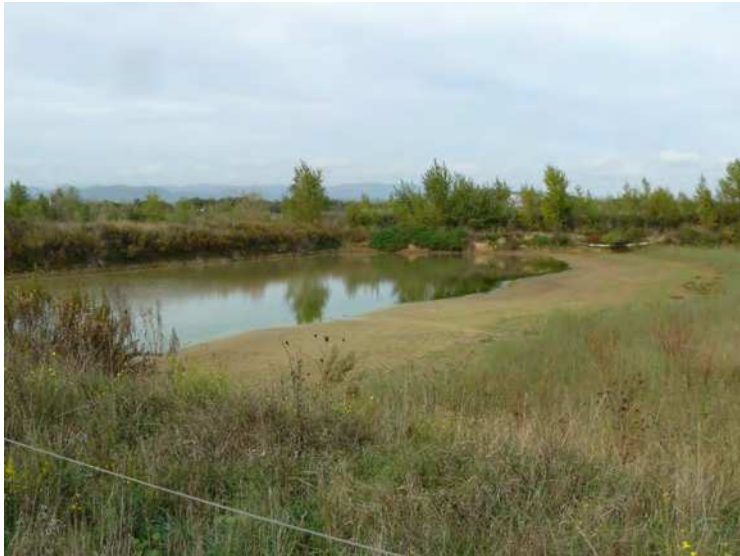
Exemple de bassin de décantation - Deux vues de détail : zone en eau sur la première, talus et végétalisation naturelle sur la deuxième
