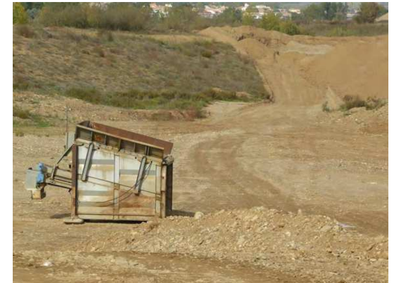
La trémie au bout de la bande transporteuse, qui sera installée
