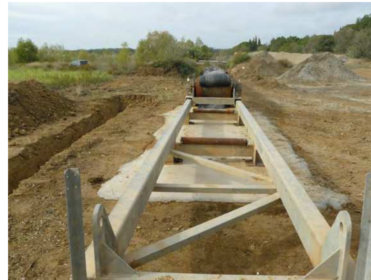
La bande transporteuse a été tronquée à la hauteur des terrains de Saint-Louis, les aménagements pour accueillir la trémie ont été réalisés et la tranchée faite pour l'alimentation électrique
