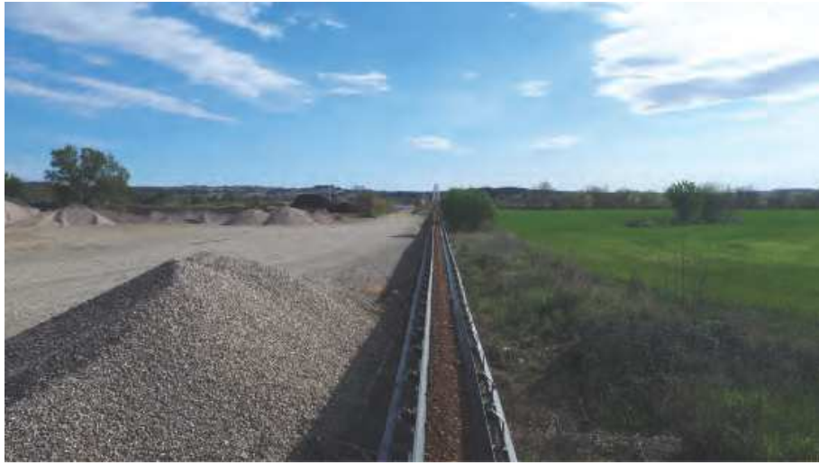
A - Tapis de plaine à la jonction de la zone de stockage des matériaux (à gauche) et des terrains à exploiter (à droite)
